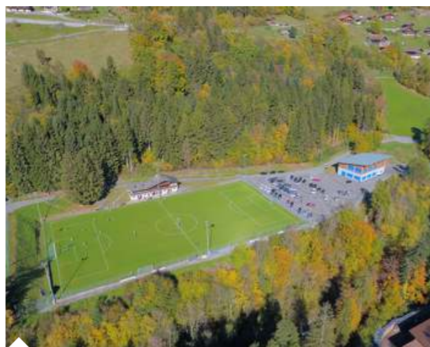
Renouvellement de l'éclairage du stade et installation de panneaux solaires sur la toiture de la salle multisport : plusieurs investissements destinés à diminuer les charges liées à l'énergie seront réalisés en 2025.
